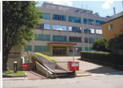
第二の高山右近屋敷跡 金沢貯金事務センター敷地
